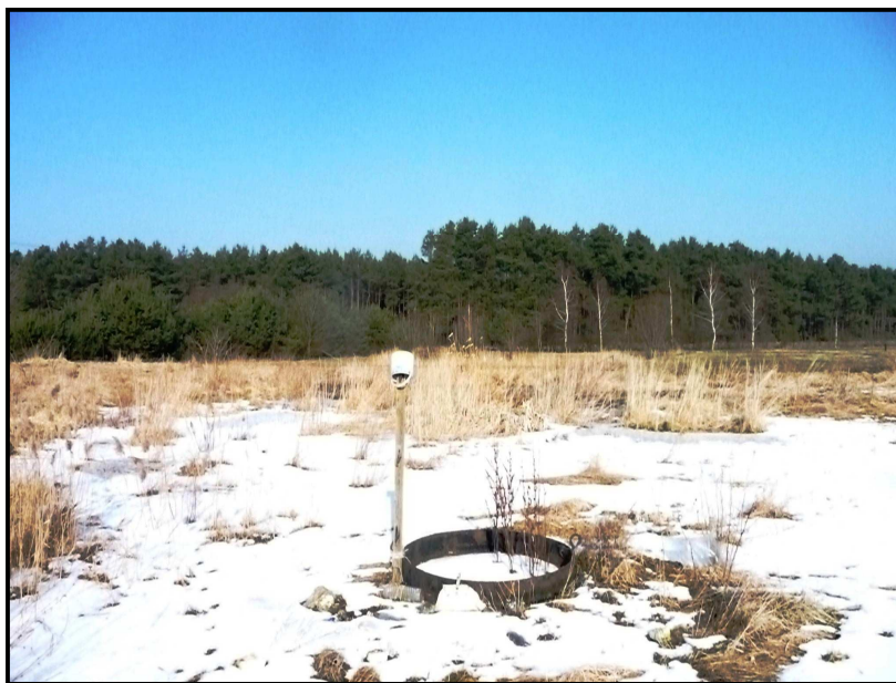
Fotografia nr 6 Studzienka odgazowująca (01.III.2011).
