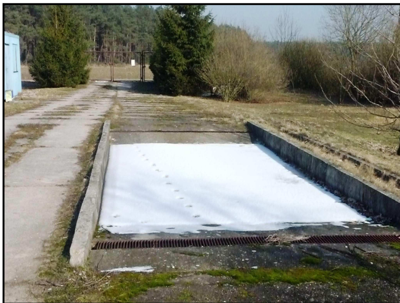
Fotografia nr 10 Brodzik dezynfekujący, zlokalizowany przy wyjeździe z terenu składowiska (01.III.2011r)
